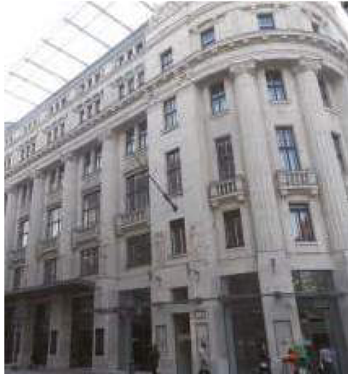
Lokalizacja: Węgry Inwestycja: Galeria handlowa
